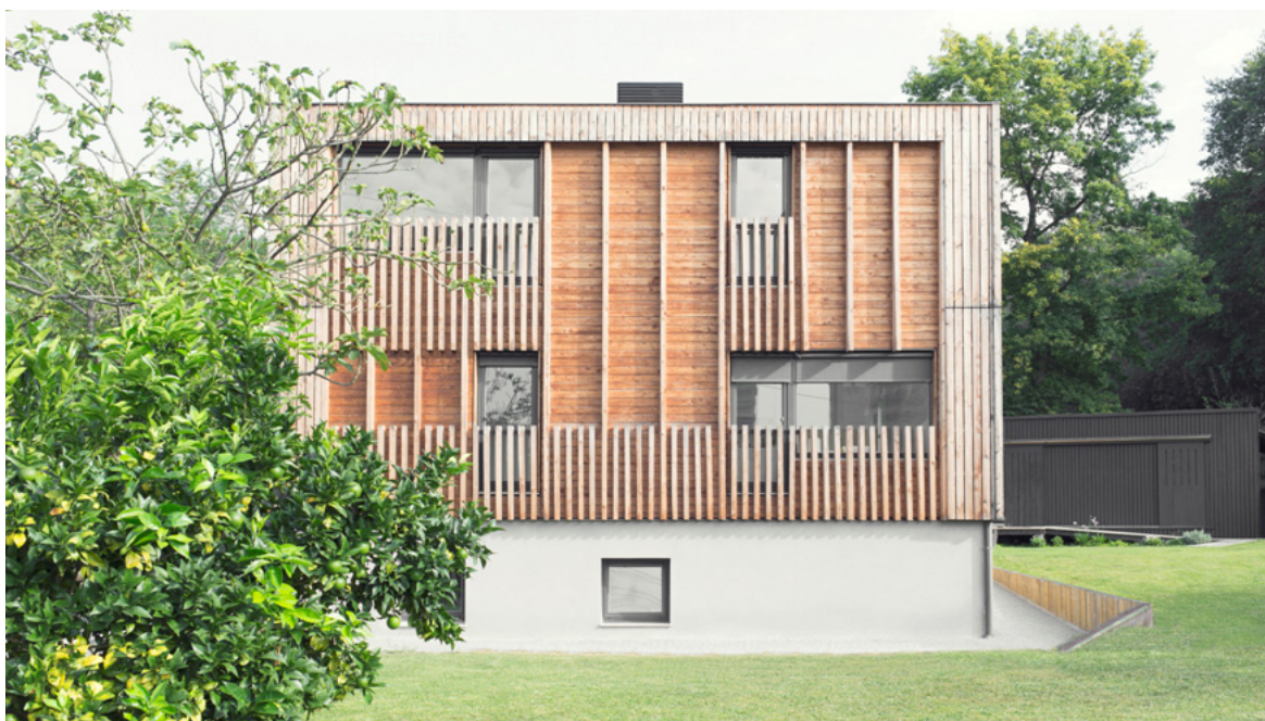
Figura 10. Imagen de la fachada sur.
