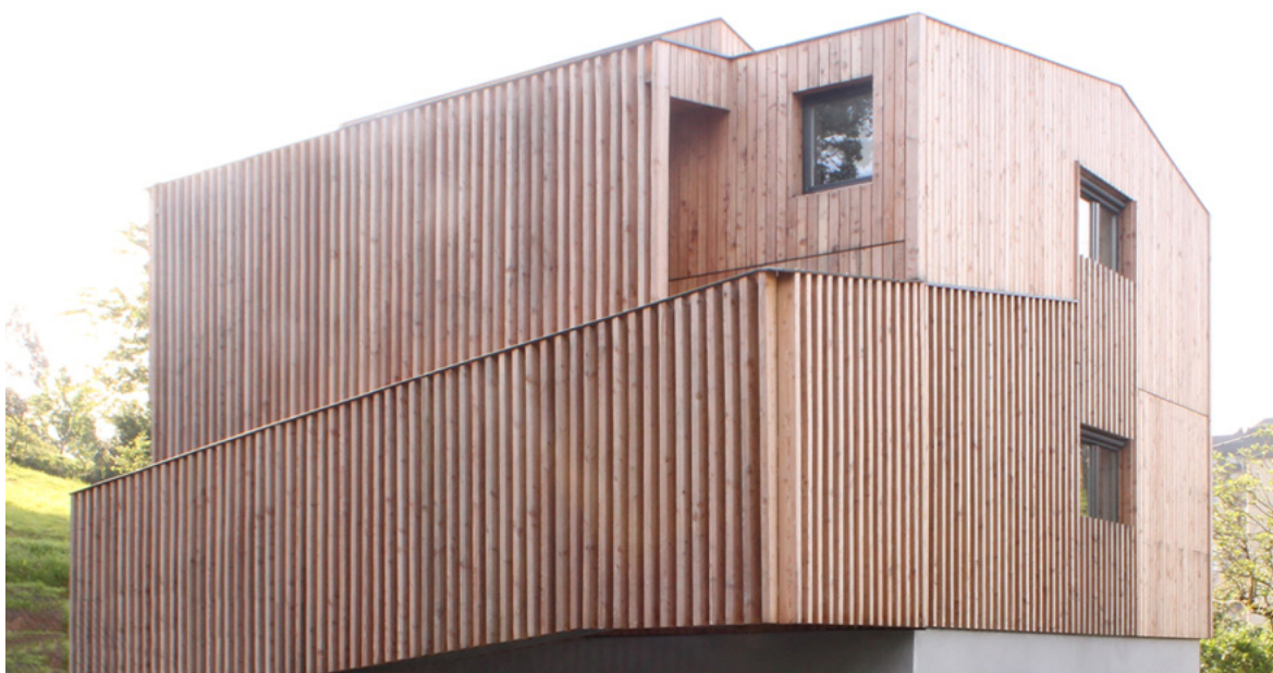
Figura 11. Imagen de las fachadas norte y oeste.
