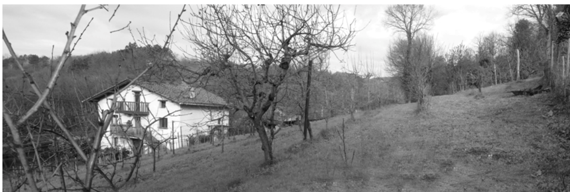
Figura 2. Estado previo de la edificación.
