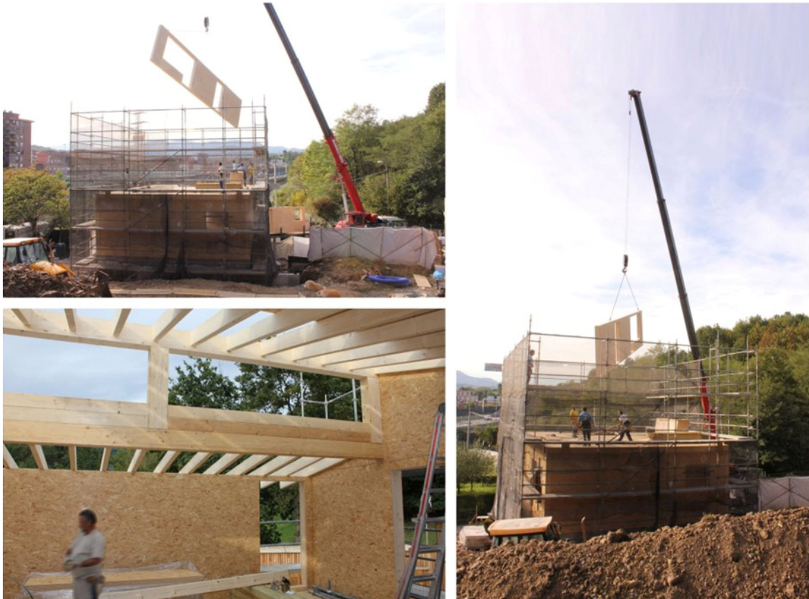
Figura 6. Proceso de construcción con paneles prefabricados de madera.
